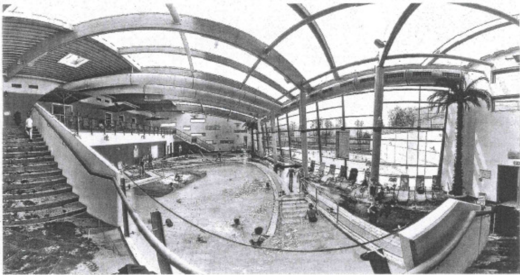
Ab Mitte Juni vorübergehend geschlossen: die Thermalhalle der Frankenalbtherme, an deren Dachbindern Revisionsarbeiten anstehen.
